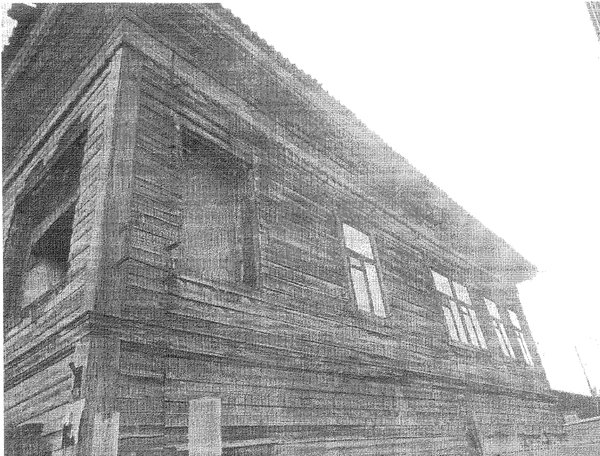
Фото 2 от 03.10.2024. Часть дворового фасада.
