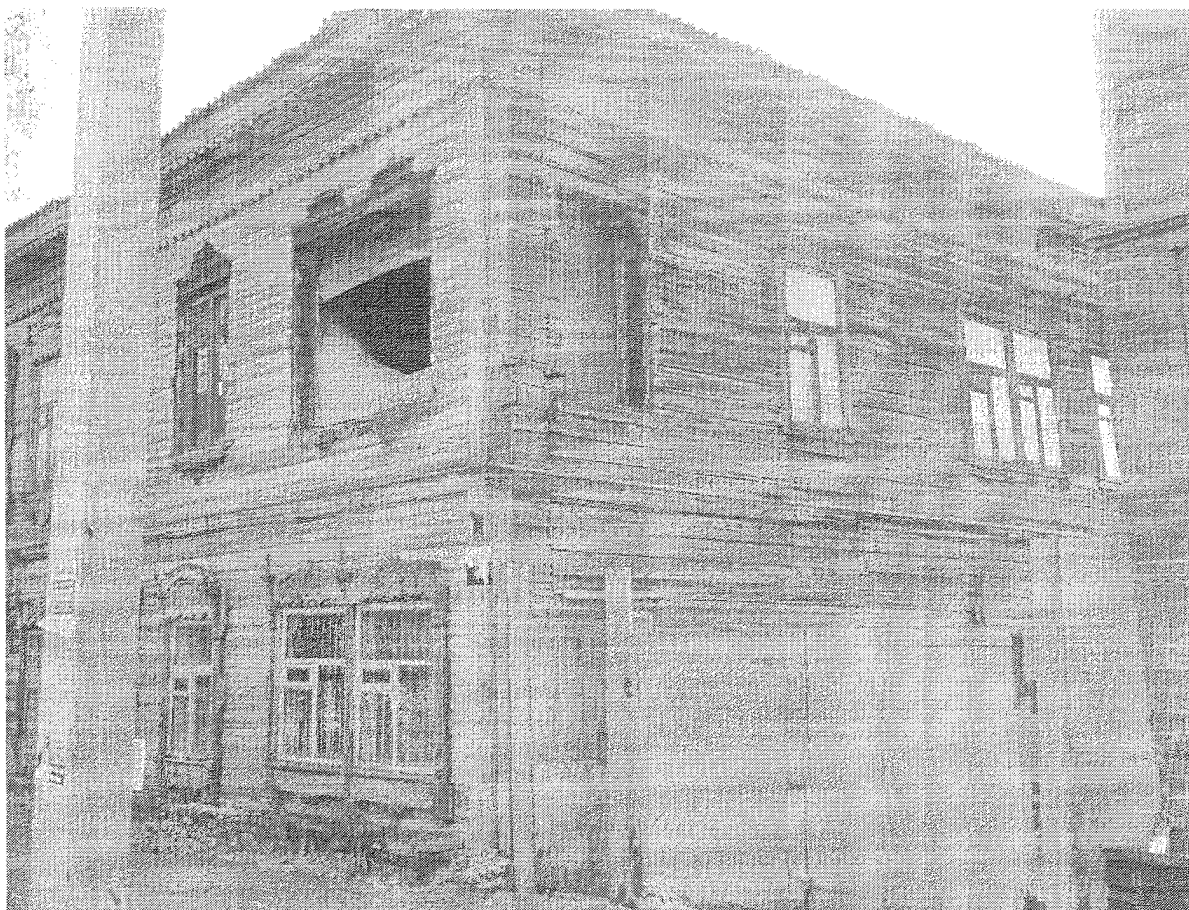
Фото 4 от 03.10.2024. Западный угол здания. Утрата наличников окон, оконных блоков.
